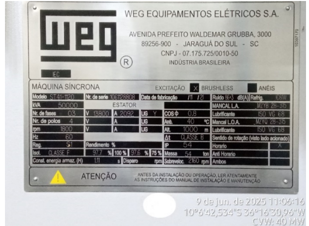
Nameplate data: Alternator/ Generator nº 6 (UTE Coruripe CVW Energética)
