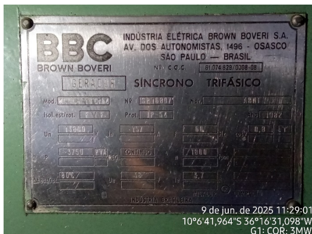
Nameplate data: Alternator/ Generator nº 1 (UTE Coruripe Usina COR)
